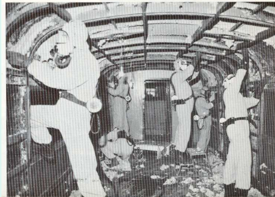
Fase di scoibentazione con utilizzo di maschera facciale
