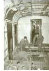
Figura 3. Raschiatura manuale dell'amianto in una carrozza. OMC, 1975.
